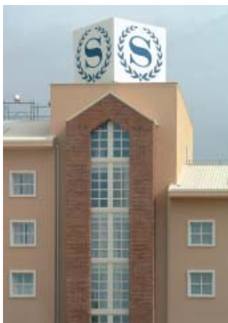
Roma, Sheraton Golf Hotel, rivestimento a cappotto con sistema Sicurwall e Cortina, 2003.
